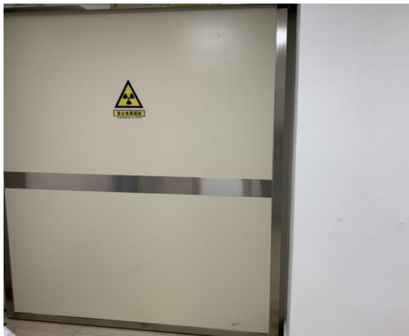
改建直加机房防护门
