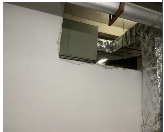
改建直加机房上方为设备层
